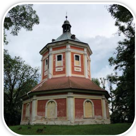
Název Kaple Panny Marie Ž3 GPS 49.8570453N, 15.3832983E
