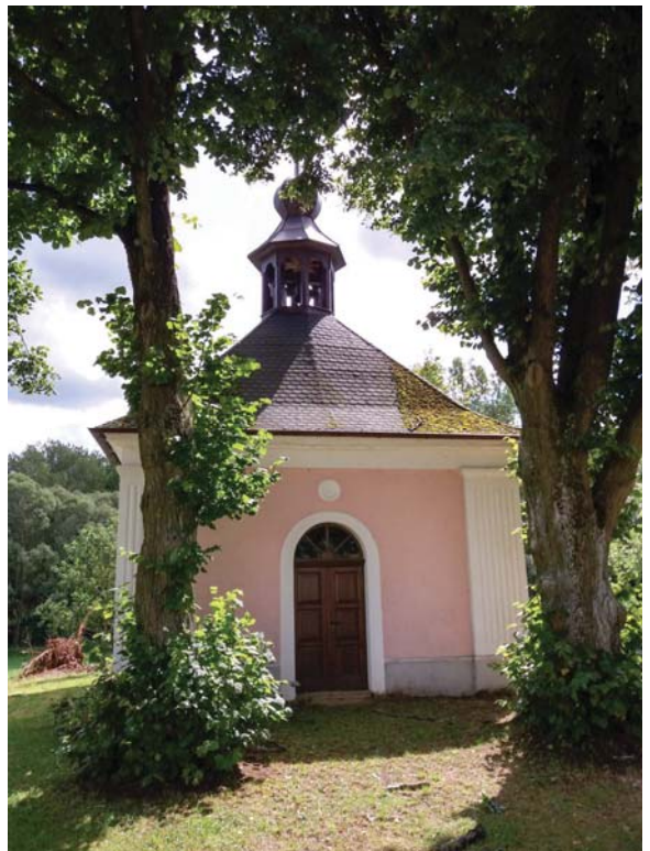
Číslo kontroly 40 Body B Název Kostel
